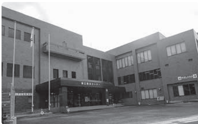
耐震補強工事を行った桜江総合センター
