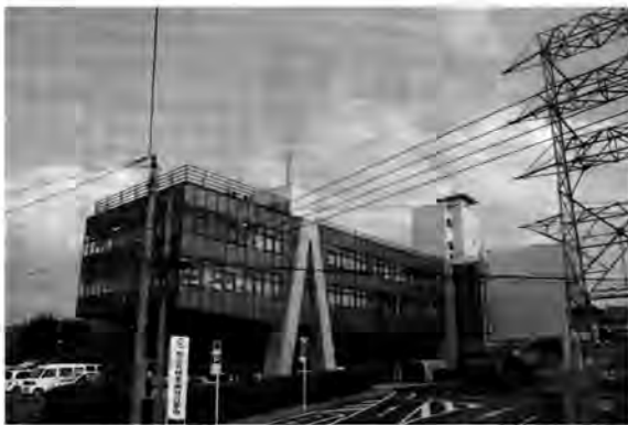
改修が課題となっている江津市庁舎
