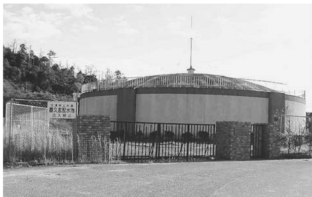
市内の上水道配水施設
