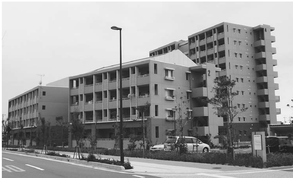
整備が続く江津中央団地
