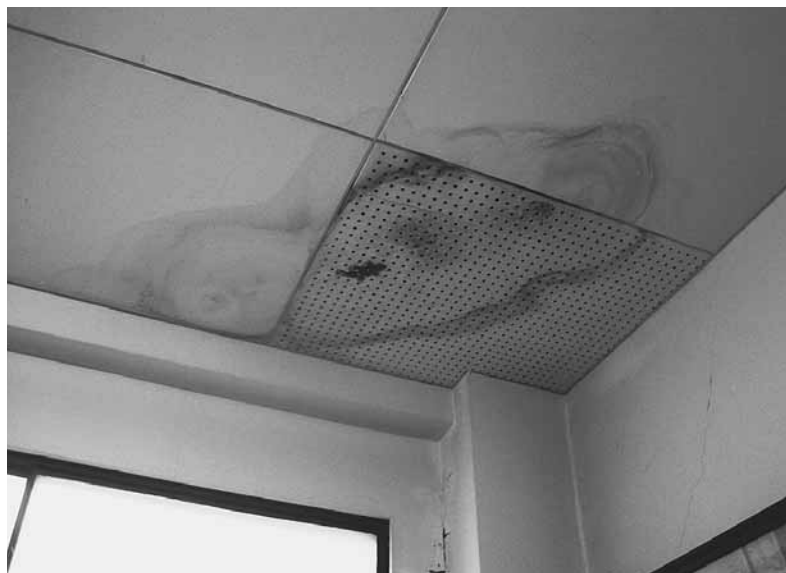
小学校校舎の雨漏りの状況
