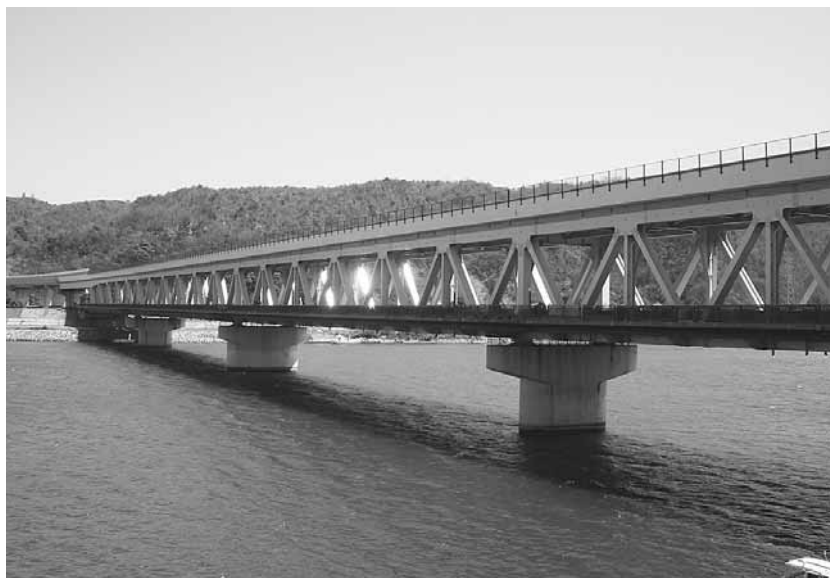
長寿命化工事が始まる新江川橋
