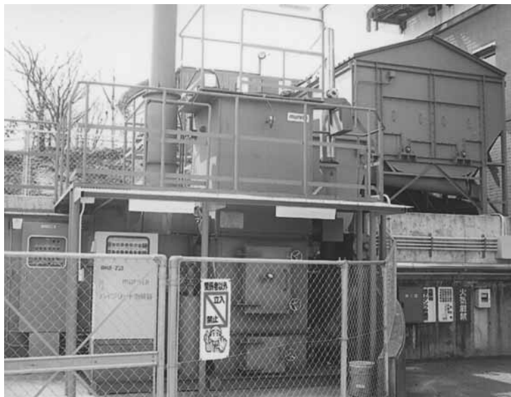
「風の国」木質バイオマスチップボイラー
