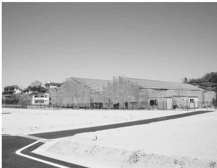
建設中の給食センター
