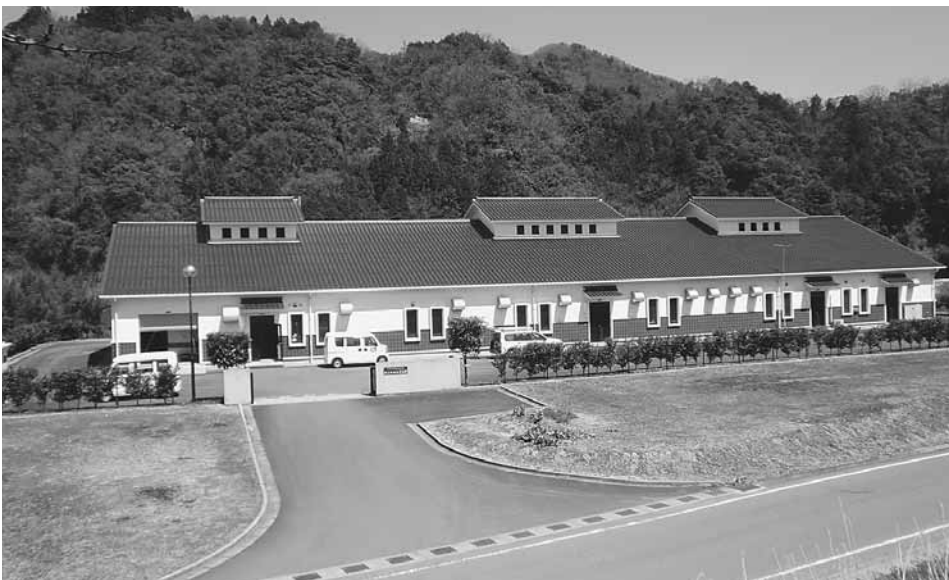
桜江町にある下水処理施設
