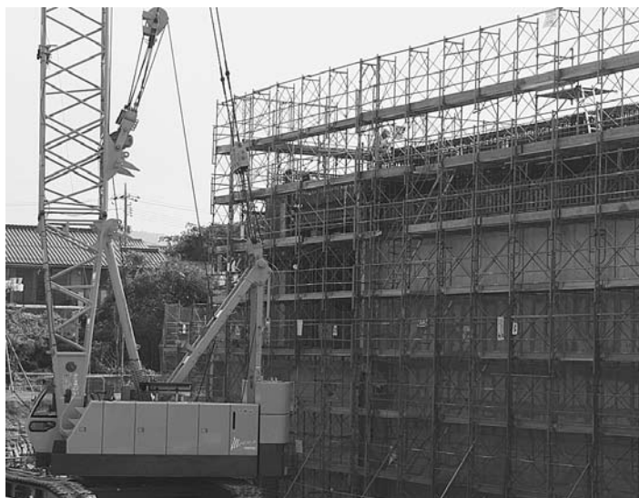
増設工事中の下水道江津西処理施設
