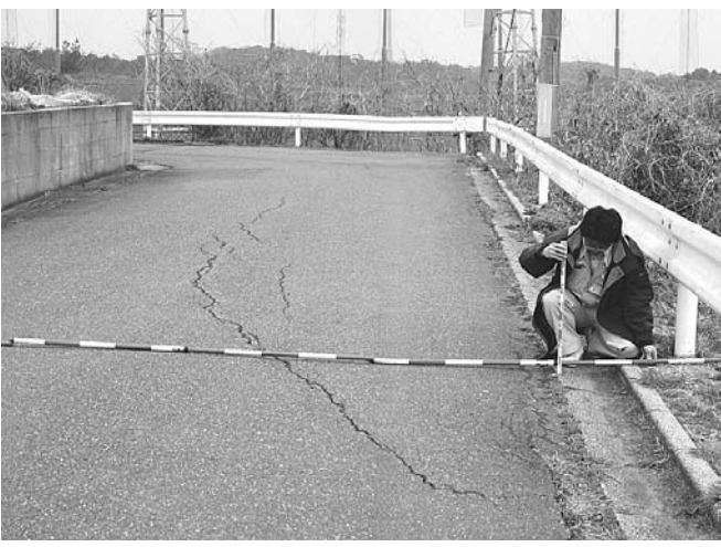
市道と木南団地2号線の状況
