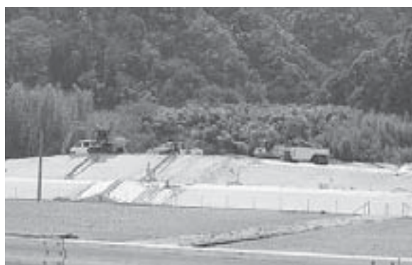
工事中的上大貫第2堤防
