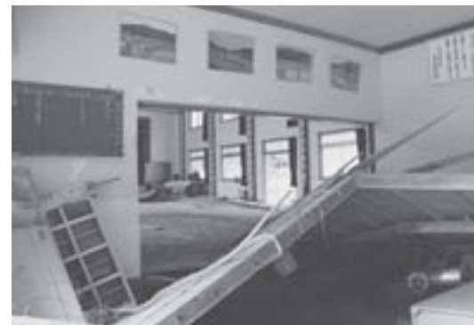
床がめくれ上がった川平公民館
