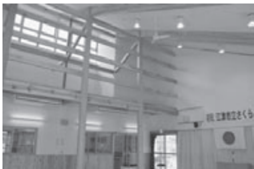
県産材を使い建設したさくらえ保育園の遊戯室
