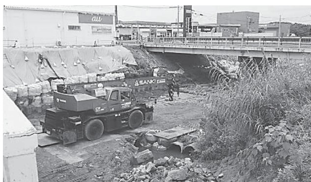
急ピッチで作業が行われている災害復旧工事現場
