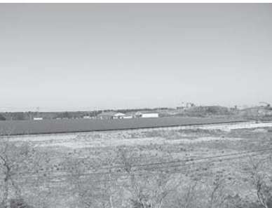
再生可能エネルギーの促進に取り組んでいます(写真は敬川町に建設中のメガソーラー)。
