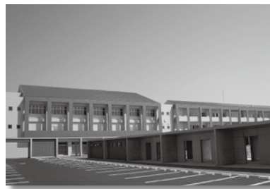
江津中学校校舎新築 (平成21年4月)
