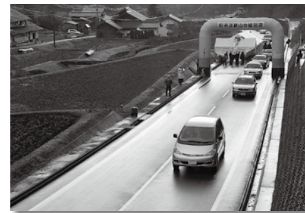
市道新山中線が開通 (平成23年12月)
