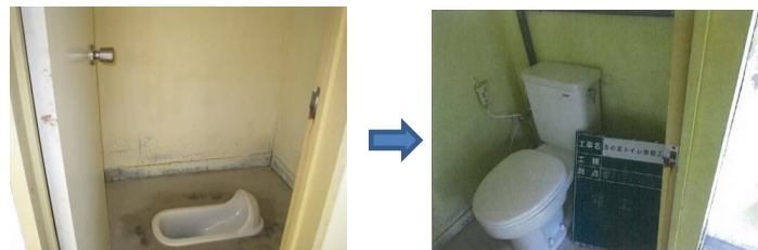
(島の星トイレ改修※洋式トイレ+簡易水洗化)
