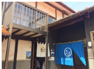
ゲストハウスに改修した 地域内外の人との交流拠点施設
