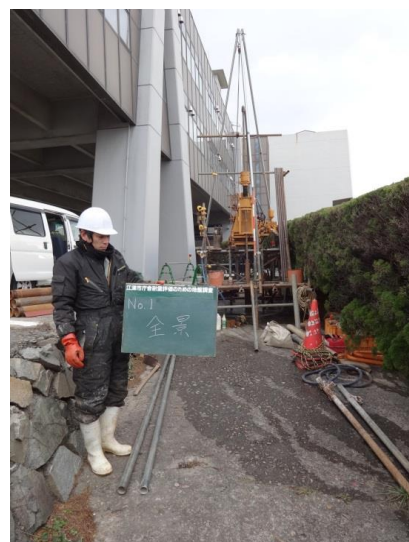
ボーリング施工箇所全景写真
