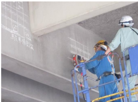
PC梁 鋼材調査状況
