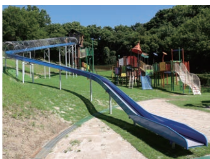
全長37メートルのローラースライダー
