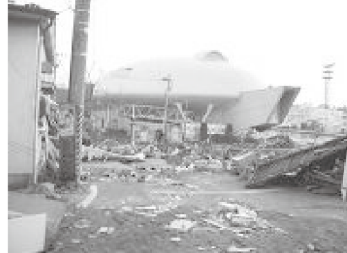
津波被害が大きかった石巻市。現在復興へ向けて取り組んでいます（石巻市提供）
