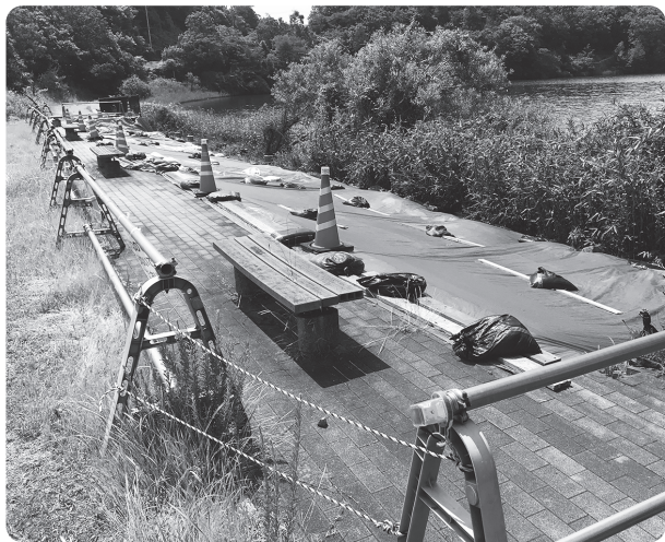
工事予定の菰沢公園園路
