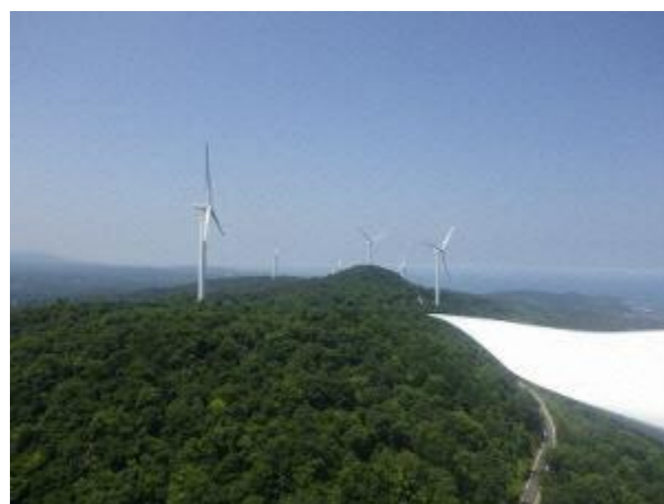
江津高野山風力発電所
