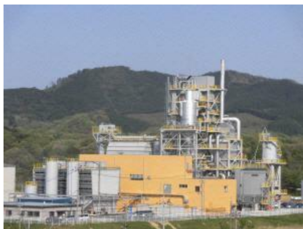
江津バイオマス発電所
