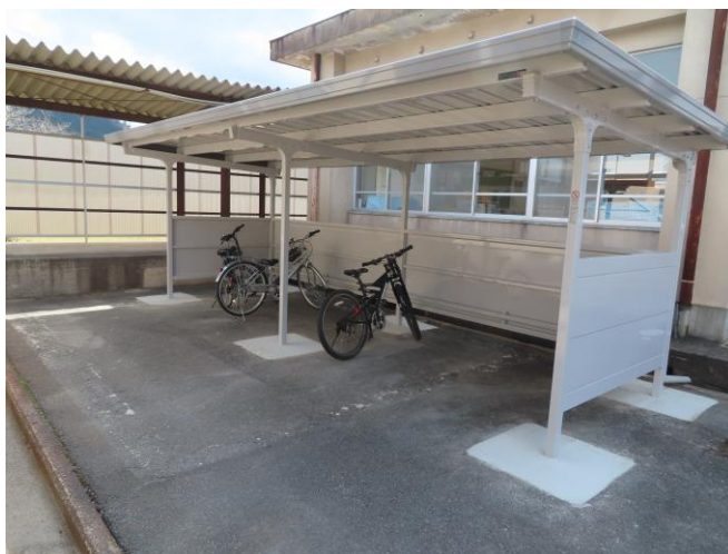
<調理室横に完成した自転車置き場>
