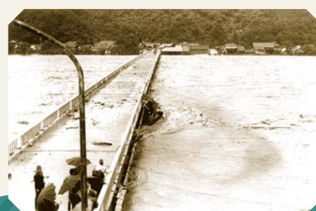
上江川橋と浸水した長田地区 (昭和47年)
