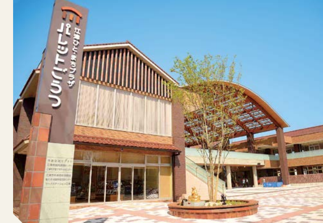
江津ひと・まちプラザパレットごうつ完成 (平成28年)
