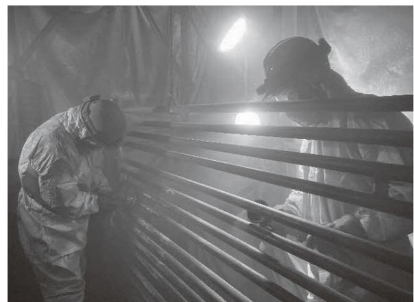
▲ボイラ水平蒸発管更新
