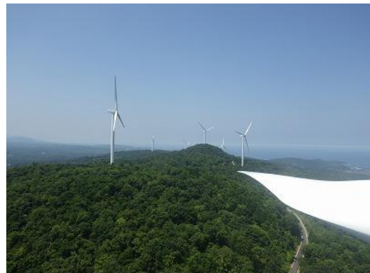
図16. 島根県「江津高野山風力発電所」
