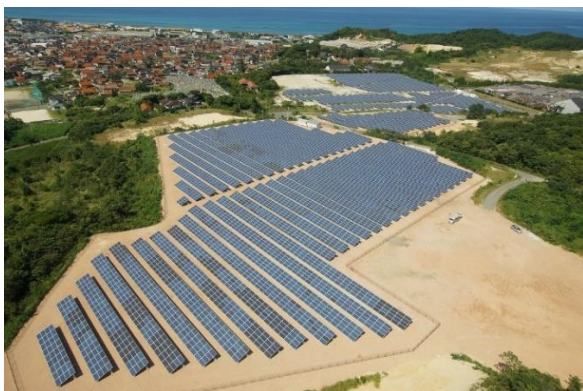
図15. (株)松江テクノサービス 「都野津ひまわりパワーステーション」
