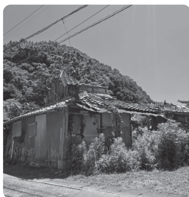
危険空き家（波津町）
