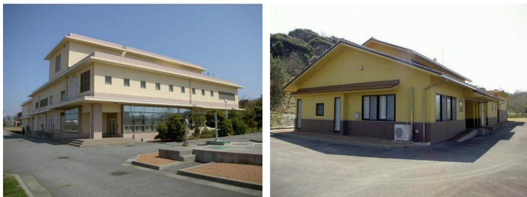
写真 左)江津西浄化センター 右)波子浄化センター
