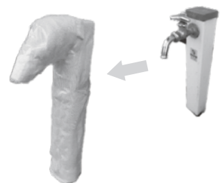
保温材(布切れ、古毛布など)を露出した水道管に巻き付け、その上からビニールテープを巻き固定する。
