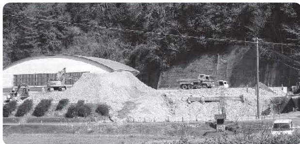
集会所を兼ねた防災拠点建設現場（川越地区）
