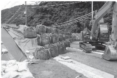
大型土のうによる仮締切(渡田地区)
